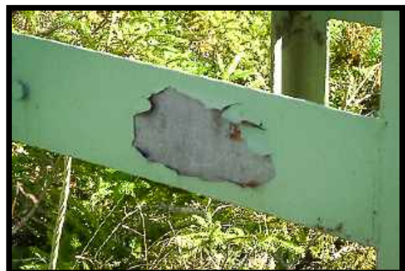
FÄRGFLAGNING FRÅN STÅLYTA MED VALSHUD
