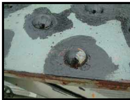
EXEMPEL PÅ KANTSTRYKNING OCH FLÄCKBÅTTRING
