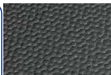
beprövad hammarslagsmönstrad yta på ovan och undersida
